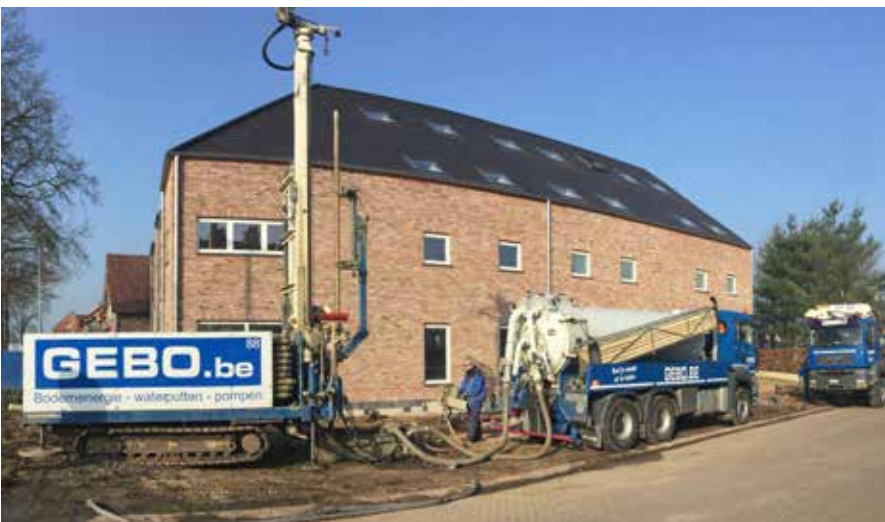
Boren van de verticale gesloten wisselaars
